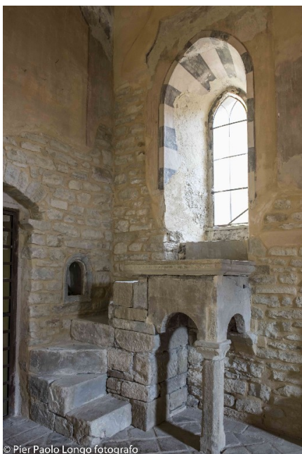
© Pier Paolo Longo fotografo
